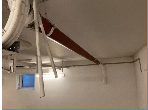
Foto 2: Faldstamme i kælder
