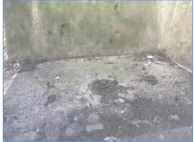
Foto 2: Afløb i lyskasse
