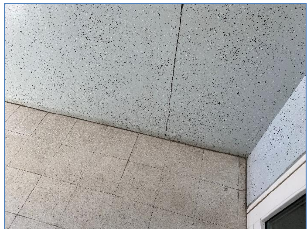
Foto 6: Revne i væg i gennemgang
