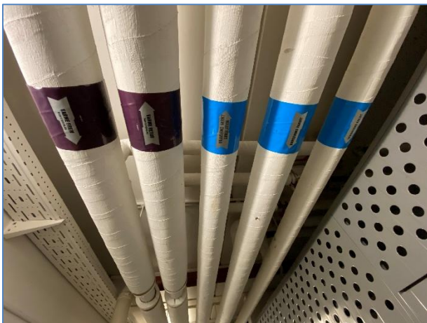
Foto 5: Fordelingsledninger i kælder
