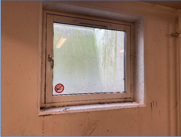
Foto 1: Kældervindue ved lyskasse
