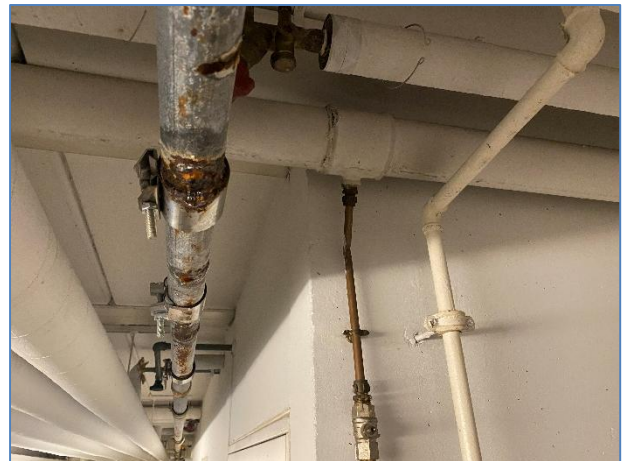
Foto 4: Utætheder på vandinstallationer
