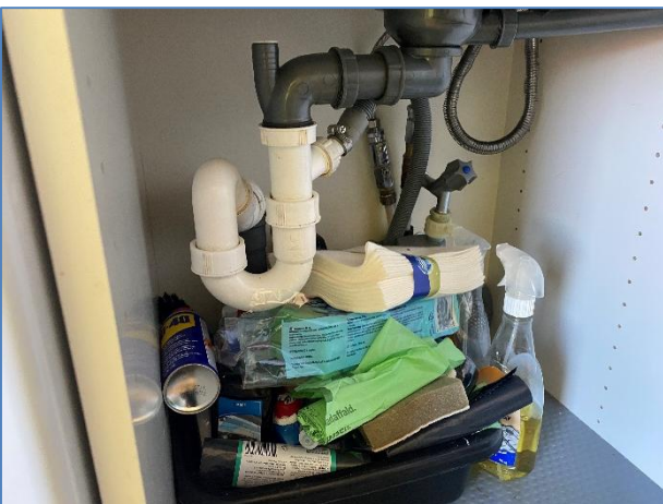
Foto 5: Afløb under køkkenvask
