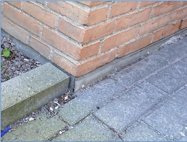
Foto 1: Sokkel mod gade
