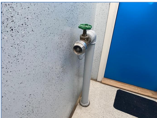
Foto 5: Stigrør i opgang
