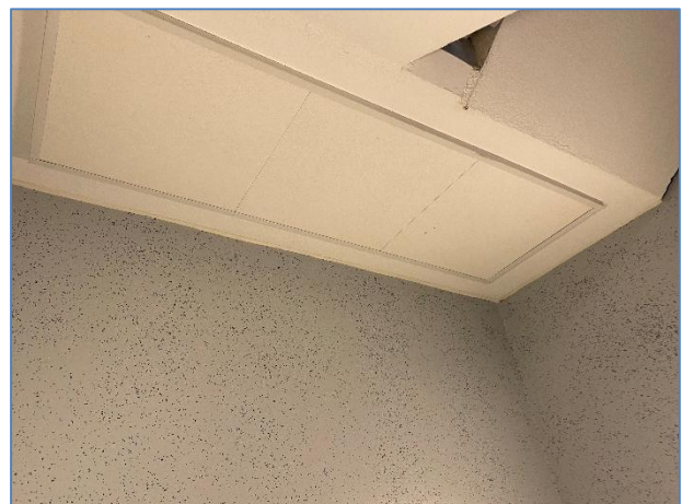
Foto 6: Akustikplader på underside repos
