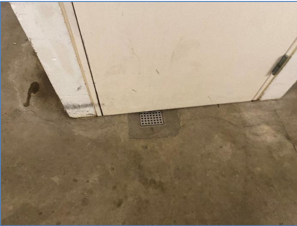
Foto 3: Gulv afløb i kælder
