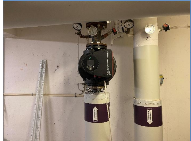
Foto 2: Cirkulationspumpe
