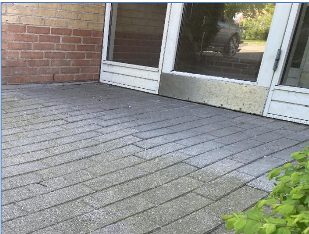
Foto 3: Niveaufri adgang ved opgange
