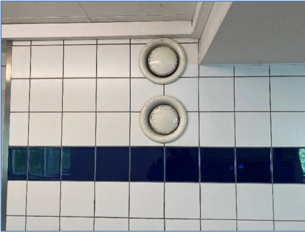
Foto 1: Ventilation i vaskekælder
