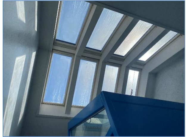
Foto 2: Vinduesparti i opgang
