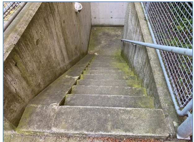
Foto 6: Kældertrappe med afløb
