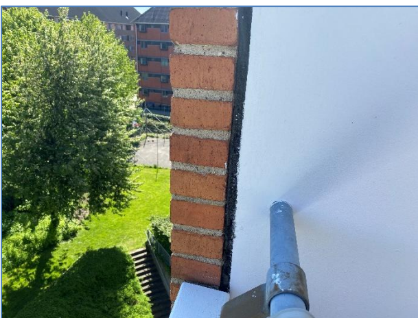
Foto 5: Ekspanderende fugebånd ved altan
